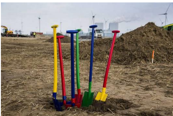
Het begin van de bouw van Googles megadatecenter bij de Eemshaven. de provincie wil nu dolgraag Tesla in huis halen © EPA
